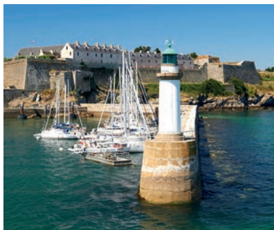
Port du Palais & la Citadelle Vauban
